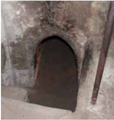
Einer der Tunnel
